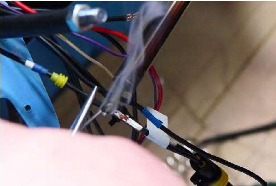
Une pince à bec pour éviter de se bruler. Toutes les connexions sont soudées avec un soin d'orfèvre. Voir plus.
