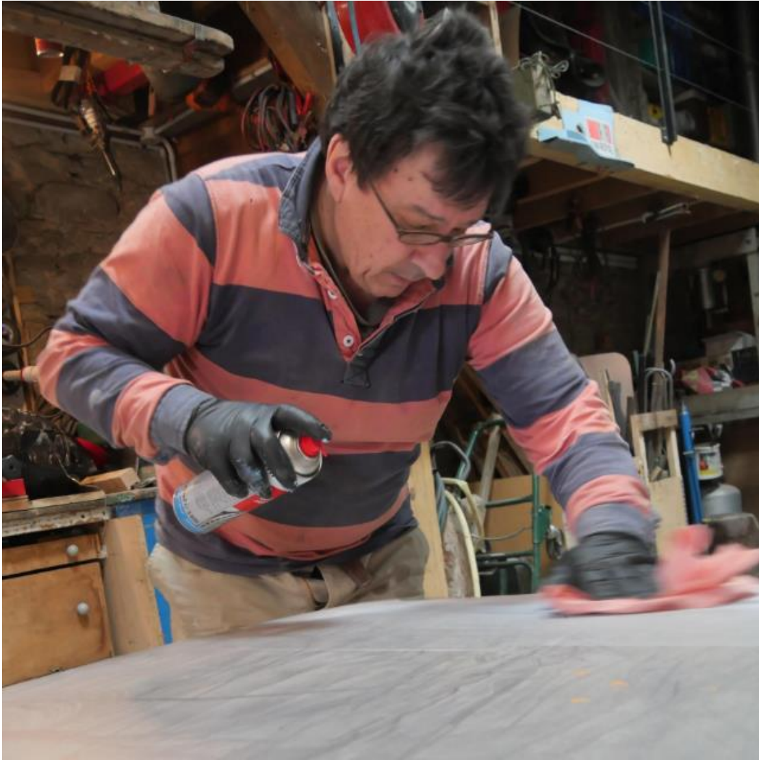
Avant la couche d'apprêt déglacage de la tôle.
